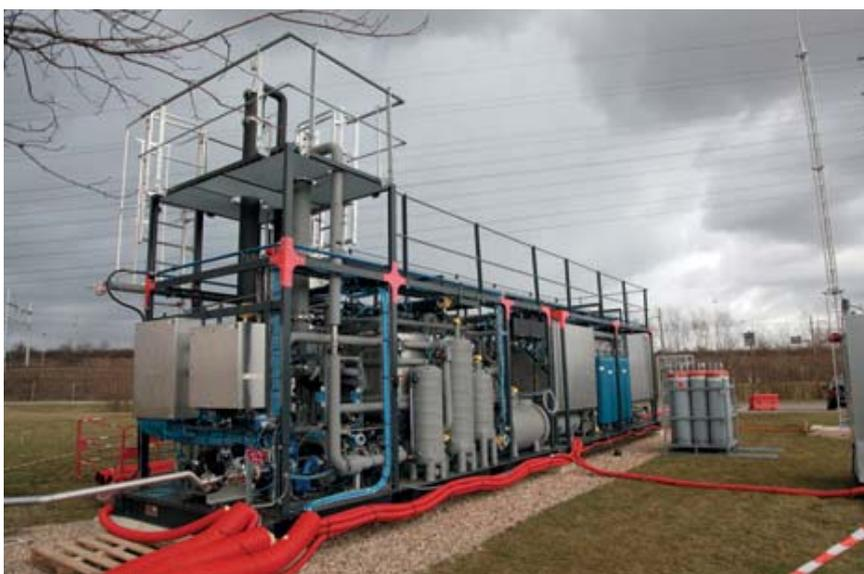
**Dans le cadre du projet BioGNVAL, le système CRYO-PUR® a été installé en mars 2015 à la station d'épuration de Valenton. Le biogaz issu des boues d'épuration est ainsi transformé en deux produits : du Bio-GNL utilisé pour le transport poids lourds longue distance et du Bio-CO2 avec un niveau de pureté permettant sa valorisation dans des applications industrielles.**
