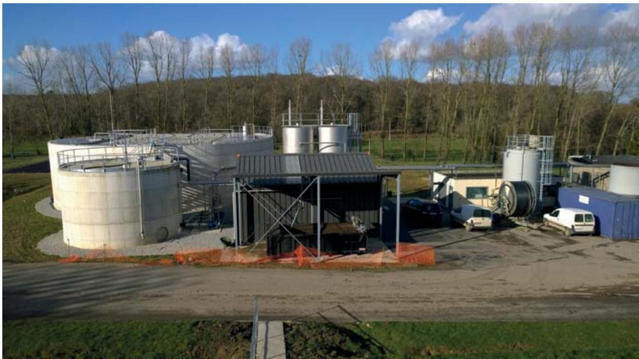
Cette installation de traitement des eaux usées industrielles, située en Bretagne, a récemment été agrandie et optimisée par Enprotech. L'extension de la station, via l'ajout d'un réacteur anaérobie, permet au site de produire de 4 600 Nm³ à 6 800 Nm³ par jour de biogaz.
