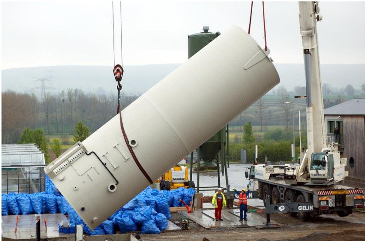
*A Cuves, dans la Manche, et à Aboncourt, en Moselle, nous traitons des biogaz complexes avec une forte présence d'hydrogène sulfuré : de la pertinence et de la qualité du prétraitement dépendent la bonne performance de la production électrique, et la préservation des équipements. A cet effet, nous avons mis en place une tour de traitement de 12 m de haut sur chacun de ces deux sites.*
